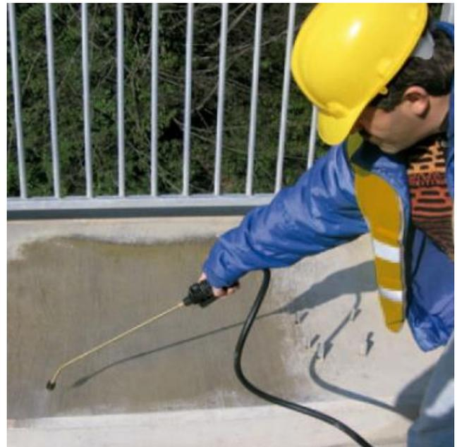
**(c) Aplicación:** La impregnación debe realizarse con brocha o rodillo en superficies pequeñas y con pistola u otros medios en superficies de gran extensión. MasterProtect H 305 se aplica normalmente en una sola capa.
